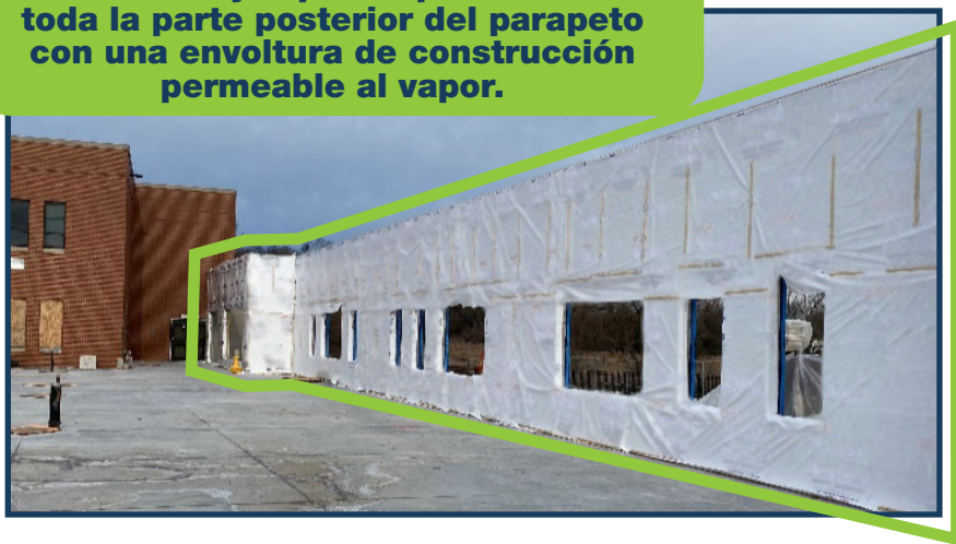
FIGURA 3 - Ejemplo de protección con lámina de plástico. Como es impermeable al vapor, no sería recomendable.
